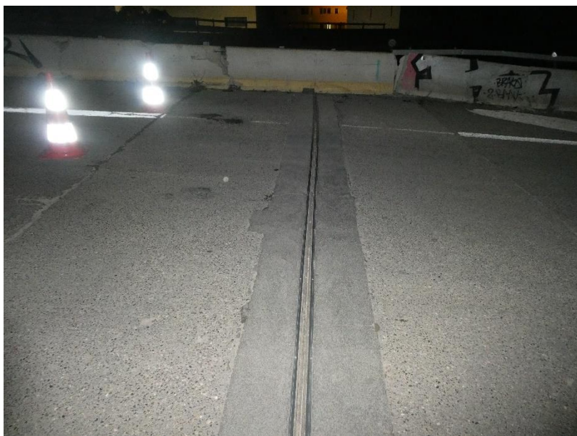
Photo 9 EQUIPEMENTS : Vue générale du joint de chaussée au droit de la culée C0'
