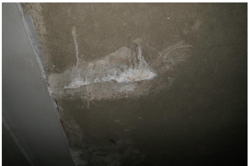
Photo 20 TABLIER - HOURDIS : Fissure transversale accompagnée de calcite sèche en sous-face du hourdis de la travée TR5 côté Sud, proche de la pile P7
