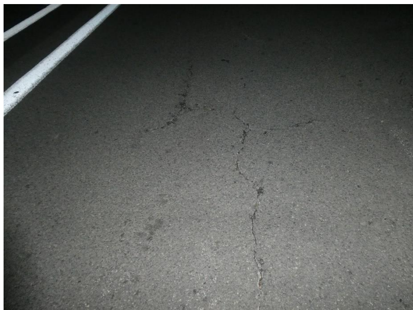
Photo 3 EQUIPEMENTS : Fissures longitudinales sur le revêtement de la chaussée, en travée TR8 proche de la culée C8
