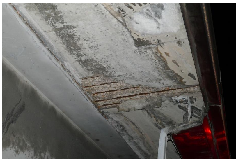
Photo 24 TABLIER - HOURDIS : Eclat de béton avec aciers apparents foisonnés en sous- face de l'encorbellement Nord en travée TR5
