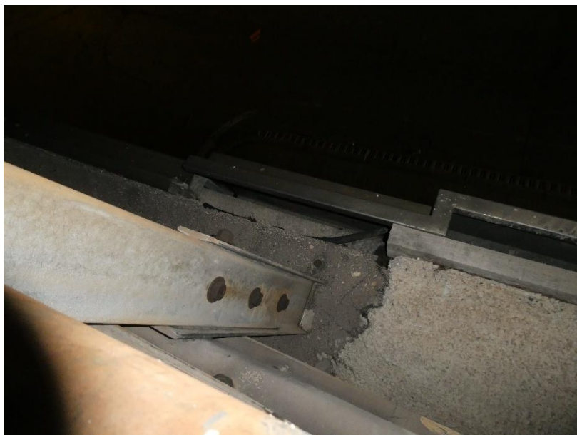
Photo 10 EQUIPEMENTS : Corrosion des boulons de fixation d'un montant du garde-corps Sud, en travée TR7
