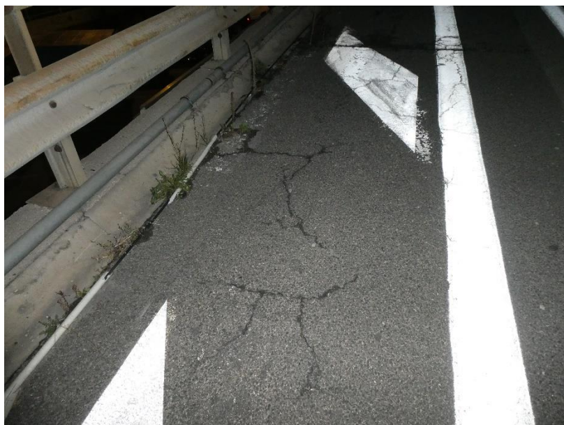
Photo 5 EQUIPEMENTS : Faïençage en rive de la chaussée côté Nord
