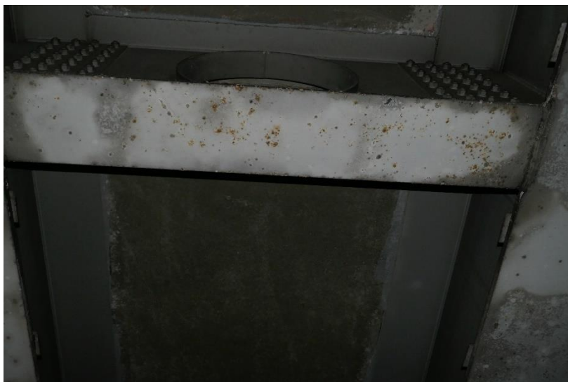
Photo 31 TABLIER - ENTRETOISES : Piqûres de corrosion en sous-face de la semelle inférieure de l'entretoise intermédiaire côté Est de la travée TR6
