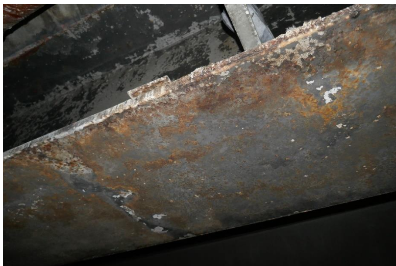
Photo 29 TABLIER - POUTRES : Corrosion au niveau de la semelle inférieure de la poutre de rive côté Nord en travée TR1 au droit de la pile P3
