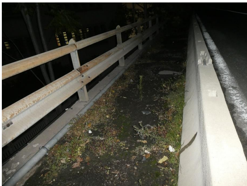
Photo 5 EQUIPEMENTS : Dépôts et végétation en rive de la chaussée côté Nord
