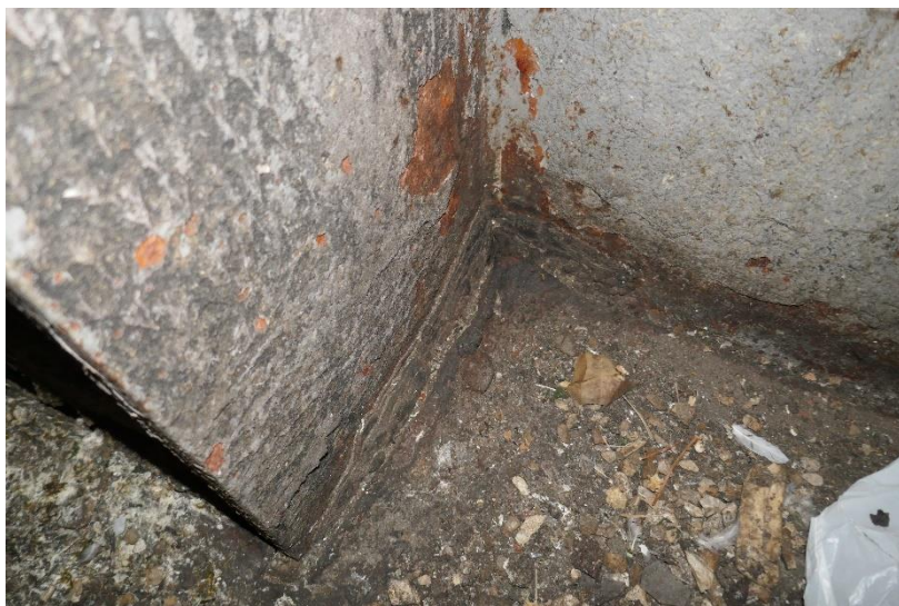
Photo 40 PILES : Corrosion foisonnante en pied de la pile P7
