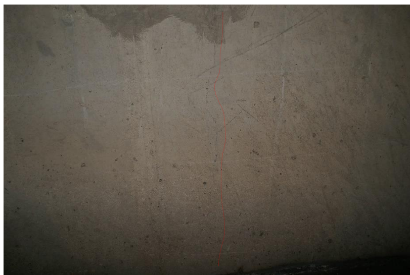
Photo 36 MURS EN RETOUR : Fissure verticale d'ouverture \mu mm sur le parement du mur en retour Nord de la culée C8 côté Ouest
