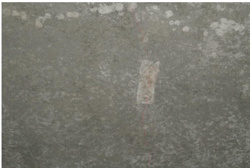
Photo 22 TABLIER - HOURDIS : Fissure longitudinale d'ouverture \mu mm en sous-face du hourdis de la travée TR4 en partie centrale
