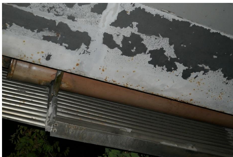
Photo 21 TABLIER - POUTRES : Ecaillage de la protection anticorrosion avec piqûres de corrosion en sous-face de la semelle inférieure de la poutre PoT05, en travée TR1 entre E1 et E2
