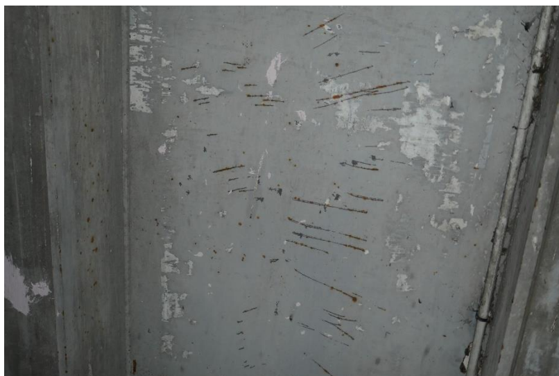
Photo 41 PILES : Eraflures avec corrosion sur la face Ouest de la pile P6
