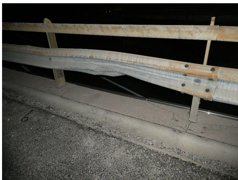
Photo 9 EQUIPEMENTS : Déformation de la glissière de sécurité côté Sud, en travée TR1
