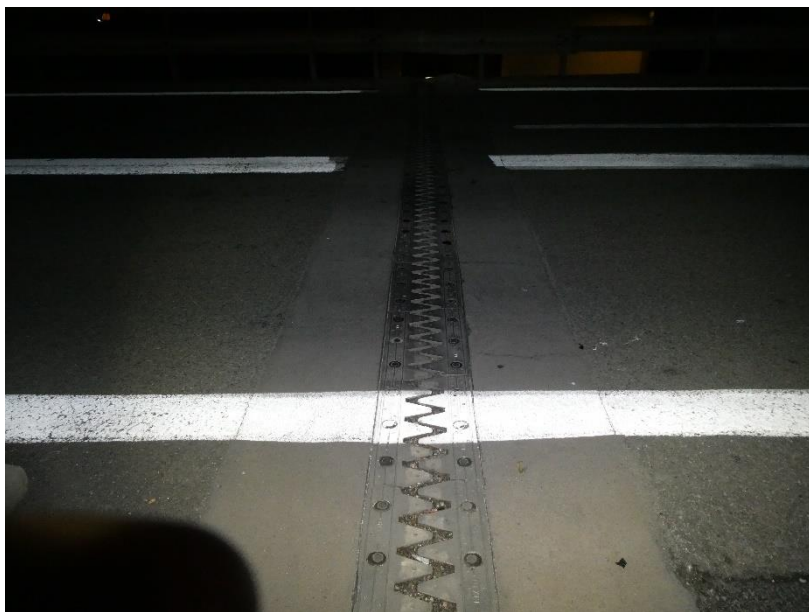
Photo 13 EQUIPEMENTS : Vue générale du joint de chaussée au droit de la pile P4
