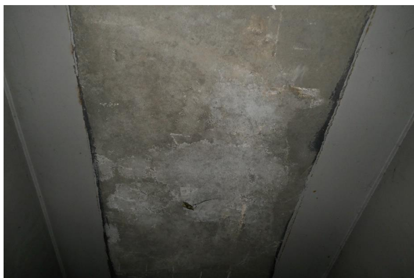
Photo 15 TABLIER - HOURDIS : Efflorescences en sous-face du hourdis intermédiaire en travée TR2 entre PoT04 et PoT05, proche de la pile P2
