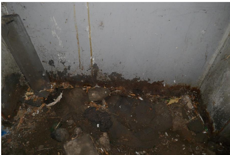
Photo 29 APPUIS - PILES : Corrosion foisonnante en pied de la pile P1 face Ouest
