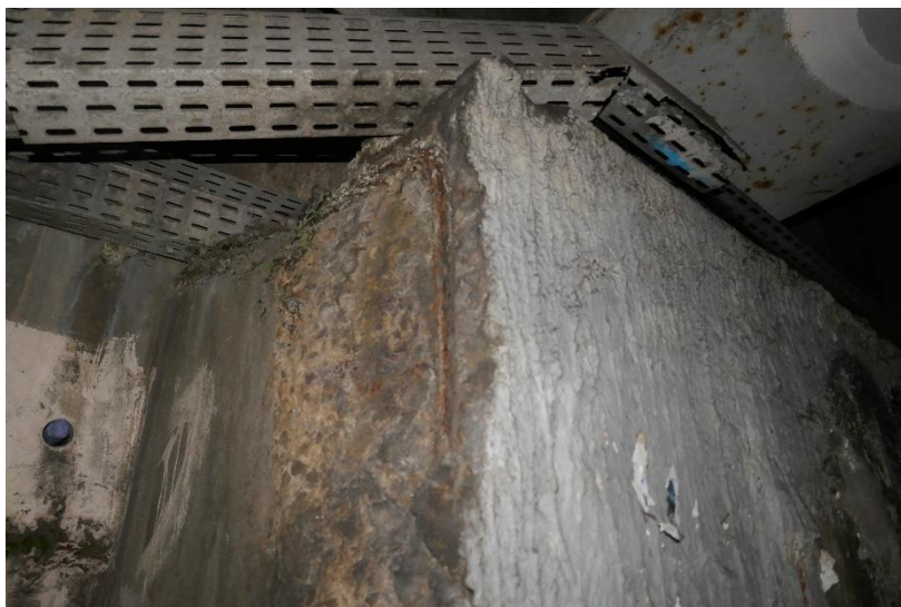
Photo 37 MURS EN RETOUR : Eclat de béton avec acier apparent foisonné à l'extrémité Est du mur en retour Sud de la culée C8
