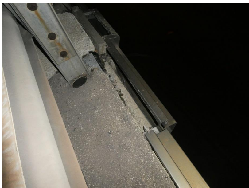
Photo 12 EQUIPEMENTS : Défaut de fixation d'un élément de corniche côté Sud au droit de la pile P6, en travée TR7
