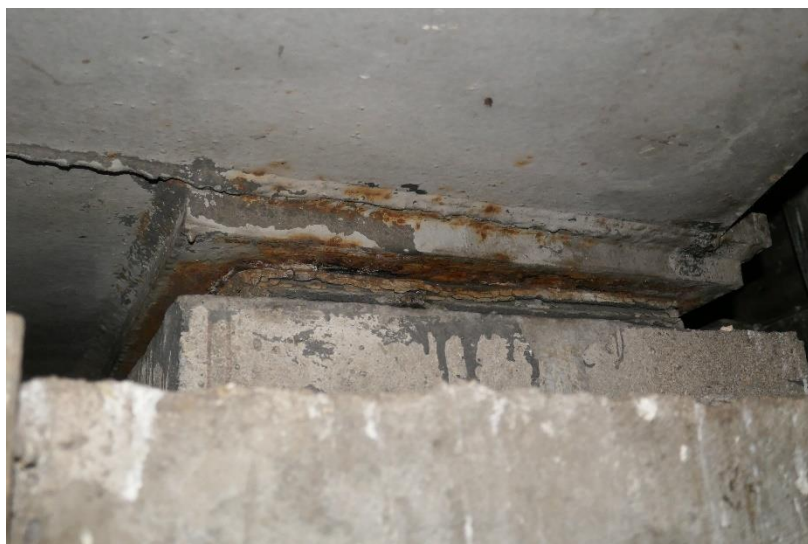
Photo 47 APPAREILS D'APPUI : Corrosion au niveau du bossage supérieur de l'appareil Nord de la pile P4
