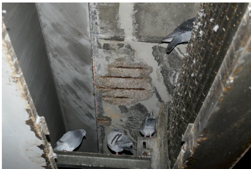
Photo 23 TABLIER - HOURDIS : Eclat de béton avec aciers apparents foisonnés en sous-face de l'encorbellement Nord en travée TR4, proche de la pile P6
