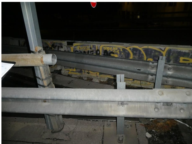
Photo 8 EQUIPEMENTS : Absence de la lisse supérieure du garde-corps côté Sud en travée TR2, proche de la pile P1
