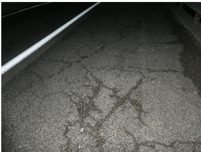
Photo 3 EQUIPEMENTS : Faïençage d'ouverture colmatée en bordure de la chaussée côté Sud
