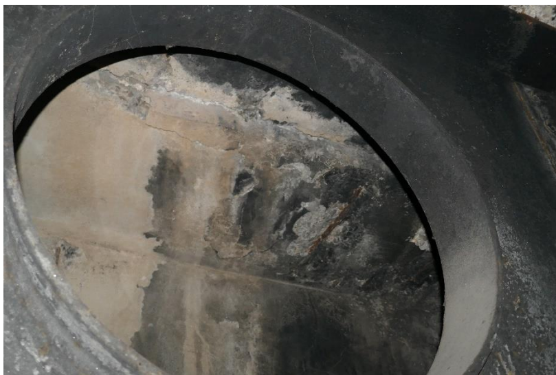
Photo 25 APPUIS - CULEES : Eclat de béton avec acier apparent foisonné en sous-face du corbeau de la culée C0'
