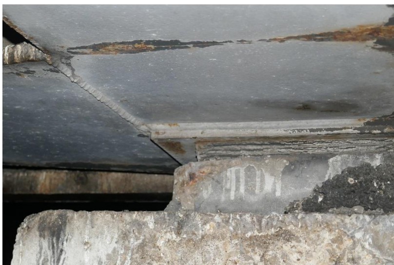
Photo 48 APPAREILS D'APPUI : Eclat de béton avec acier apparent foisonné au niveau du bossage inférieur de l'appareil d'appui Sud de la pile P4
