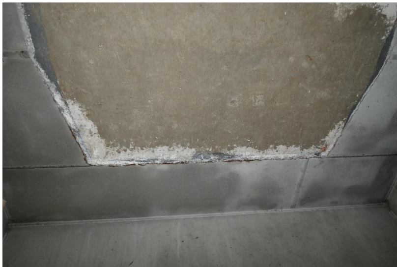
Photo 19 TABLIER - HOURDIS : Calcite sèche en sous-face du hourdis au droit de la pile P4, en travée TR6
