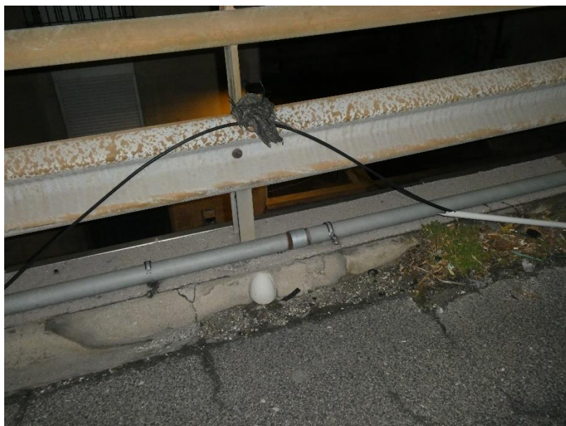
Photo 11 EQUIPEMENTS : Défaut de fixation d'un câble électrique au droit du garde- corps Nord
