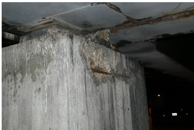
Photo 42 PILES : Eclat de béton avec acier apparent foisonné en partie haute de la face Ouest du fût côté Sud de la pile P4
