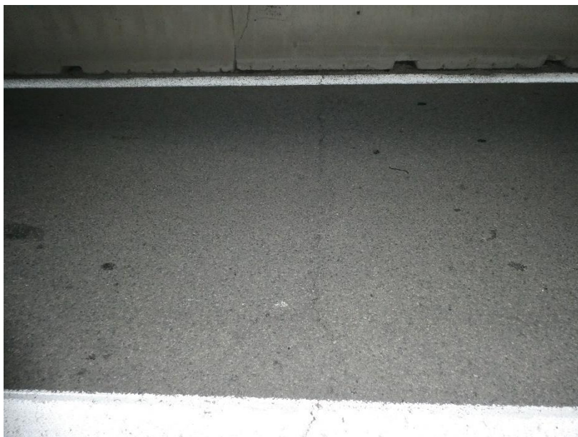
Photo 4 EQUIPEMENTS : Fissure transversale sur le revêtement de la chaussée sur ouvrage, au niveau de la travée TR4
