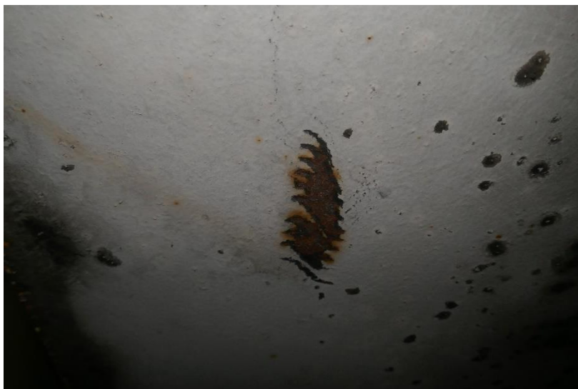
Photo 28 TABLIER - POUTRES : Erafure et corrosion en sous-face de la semelle de la poutre intermédiaire de la travée TR5, proche de la pile P6
