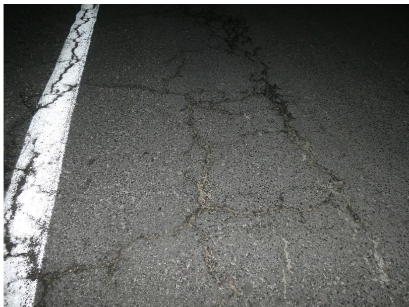
Photo 3 EQUIPEMENTS : Faïençage d'ouverture colmatée sur le revêtement de la chaussée en travée TR1 côté Sud
