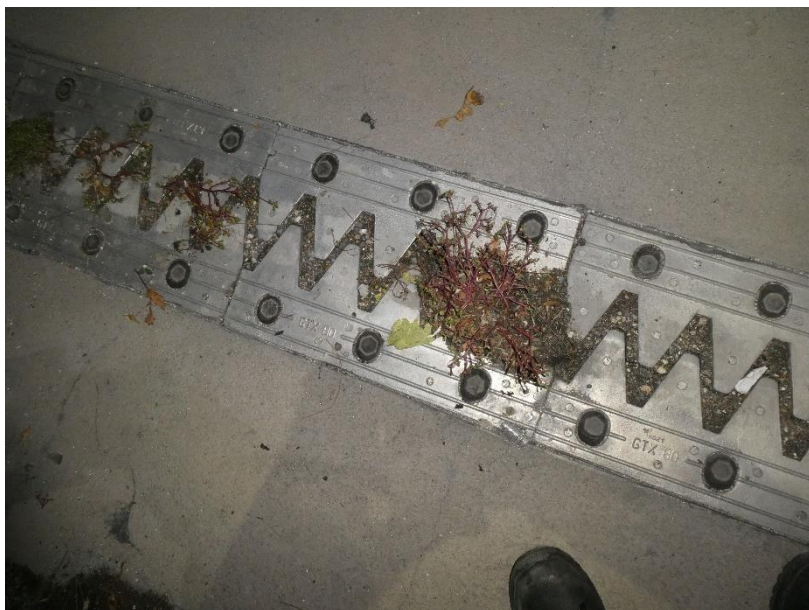
Photo 16 EQUIPEMENTS : Dépôts et végétation dans le joint de chaussée au droit de la pile P4
