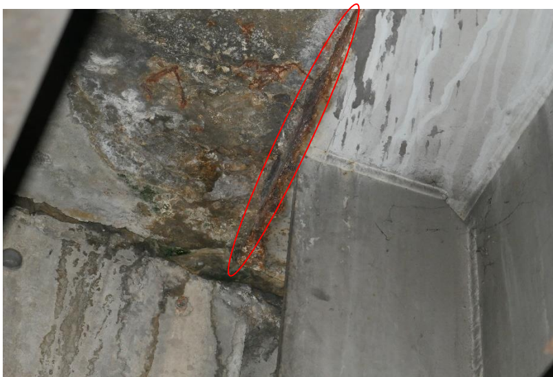
Photo 26 TABLIER - POUTRES : Corrosion foisonnante au niveau de l'arrête de la semelle supérieure de la poutre de rive côté Nord, au droit de la culée C8
