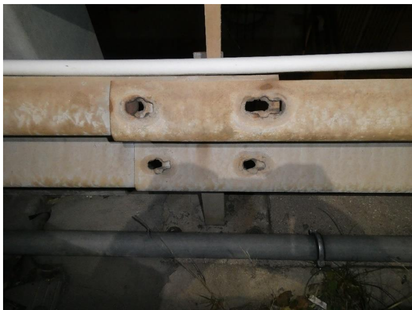
Photo 8 EQUIPEMENTS : Absence des boulons de fixation de la glissière de sécurité Nord en travée TR5 proche de la pile P4
