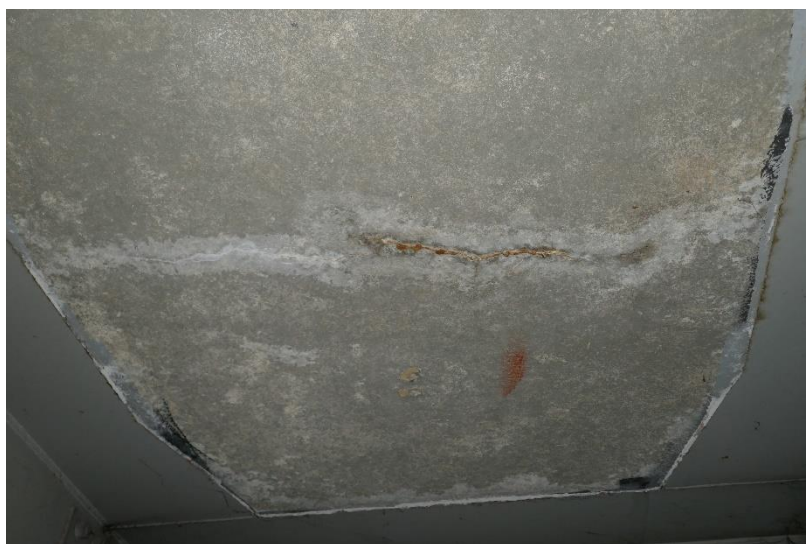
Photo 14 TABLIER - HOURDIS : Fissure transversale accompagnée de calcite sèche en sous-face du hourdis intermédiaire en travée TR2 entre PoT04 et PoT05, au droit de la pile P1
