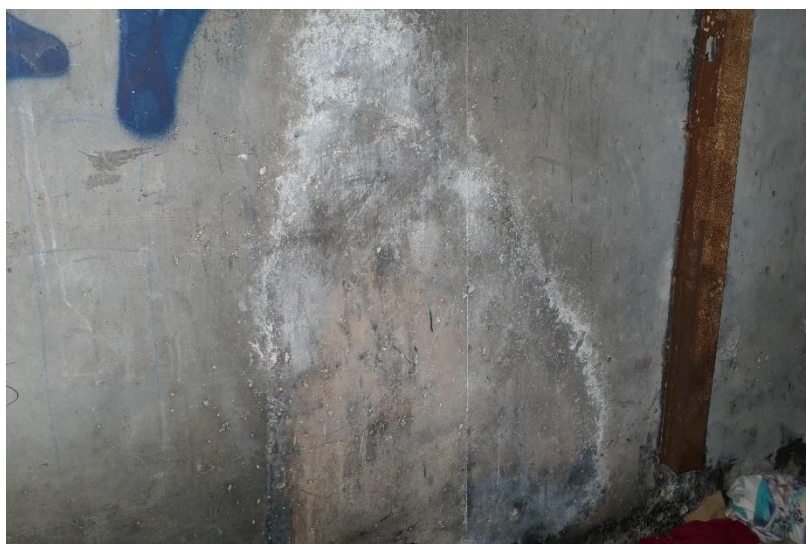
Photo 23 APPUIS - CULEES : Efflorescences sur le parement du mur de front de la culée C0'
