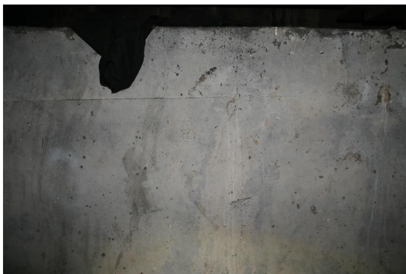
Photo 26 APPUIS - CULEES : Fissure verticale d'ouverture \mu mm sur le parement du mur de front de la culée C0' côté Ouest
