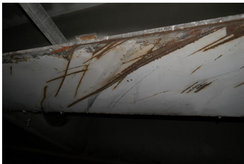
Photo 27 TABLIER - POUTRES : Traces d'éraflures et corrosion en sous-face de la semelle inférieure de la poutre de rive Sud, en travée TR5 proche de la pile P7
