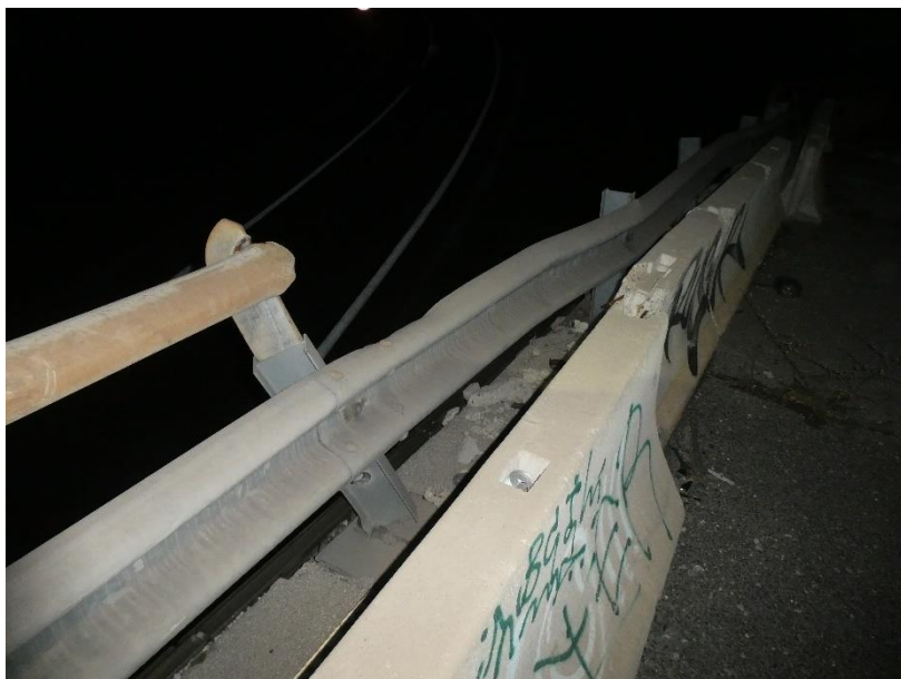
Photo 7 EQUIPEMENTS : Absence de la lisse supérieure du garde-corps Nord en travée TR2, proche de P1'
