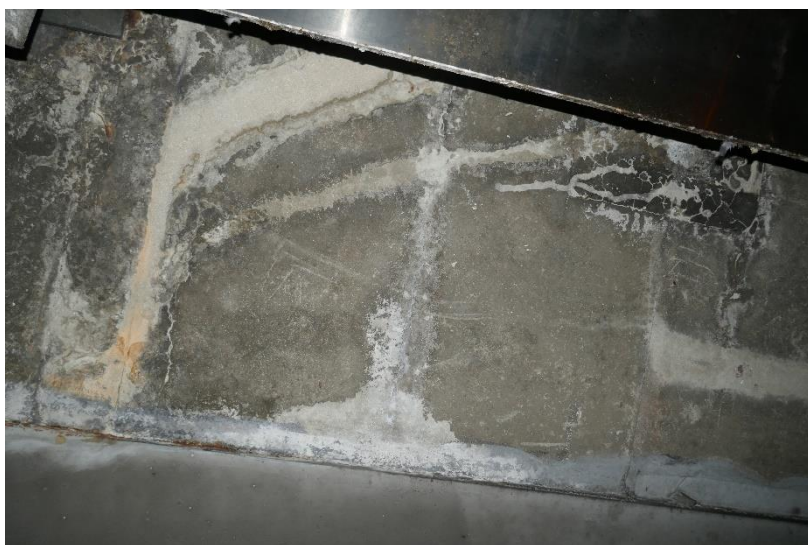
Photo 21 TABLIER - HOURDIS : Fissure transversale accompagnée de calcite sèche en sous-face de l'encorbellement Sud, au niveau de la travée TR6 côté Sud, proche de la pile P7
