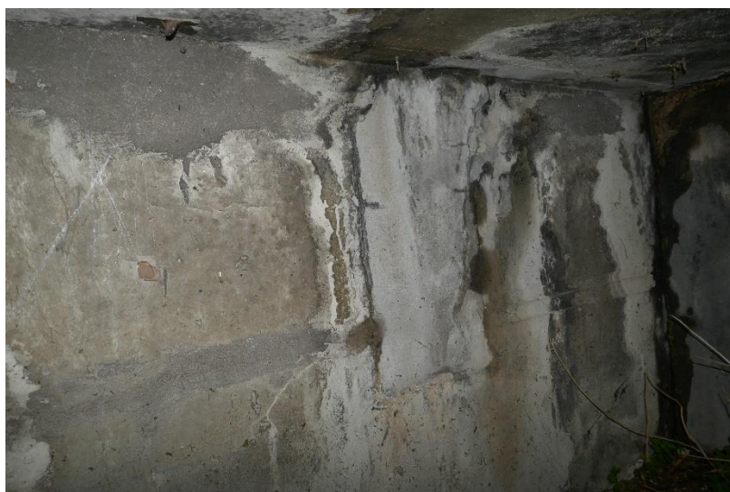
Photo 29 APPUIS - MURS EN RETOUR : Deux fissures verticales accompagnées de calcite sèche sur le parement du mur en retour côté Sud de la culée C0'
