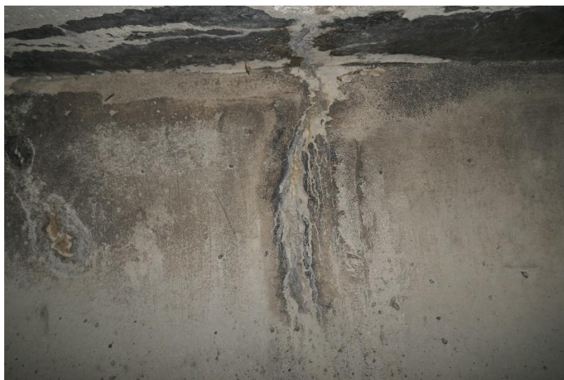
Photo 35 MURS EN RETOUR : Deux fissures verticales descendantes accompagnées de calcite sèche en partie haute du mur en retour Nord de la culée
