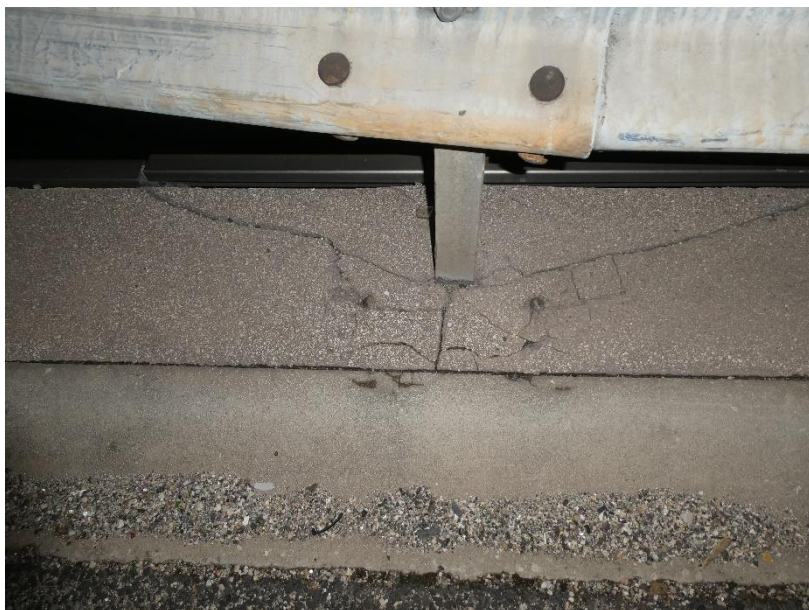
Photo 7 EQUIPEMENTS : Eclat de béton en formation en pied d'un montant du garde-corps
