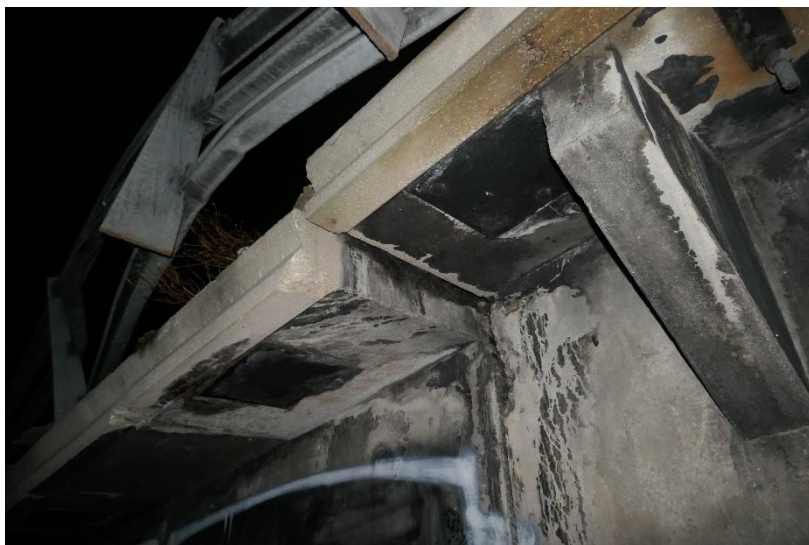
Photo 28 APPUIS - MURS EN RETOUR : Décalage altimétrique de 140 mm entre deux éléments du mur en retour côté Nord de la culée C0'
