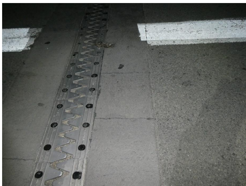
Photo 15 EQUIPEMENTS : Fissures transversales sur le solin du joint de chaussée au droit de la pile P4
