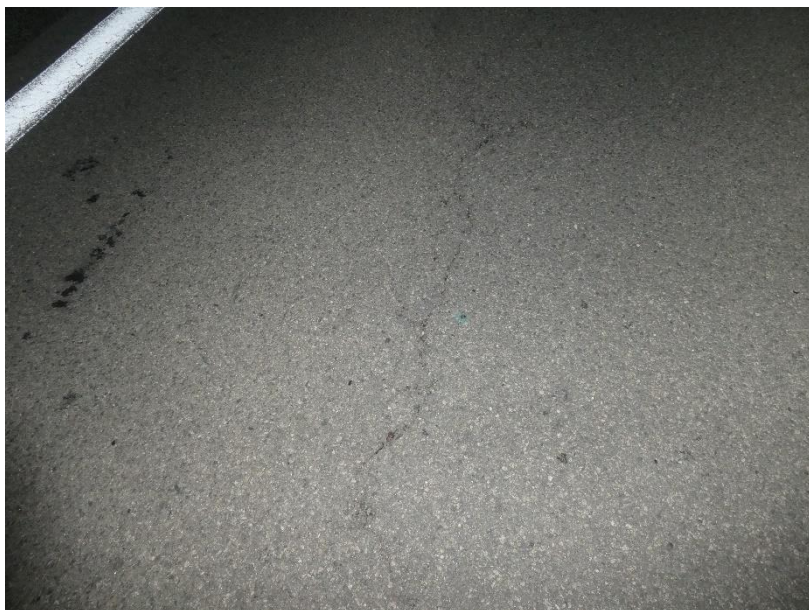
Photo 4 EQUIPEMENTS : Fissure longitudinale d'ouverture colmatée sur le revêtement de la chaussée côté Sud, au droit de la culée C0
