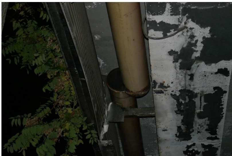
Photo 19 TABLIER - HOURDIS : Défaut de raccord du réseau d'évacuation d'eau en sous-face du tablier, en rive côté Nord
