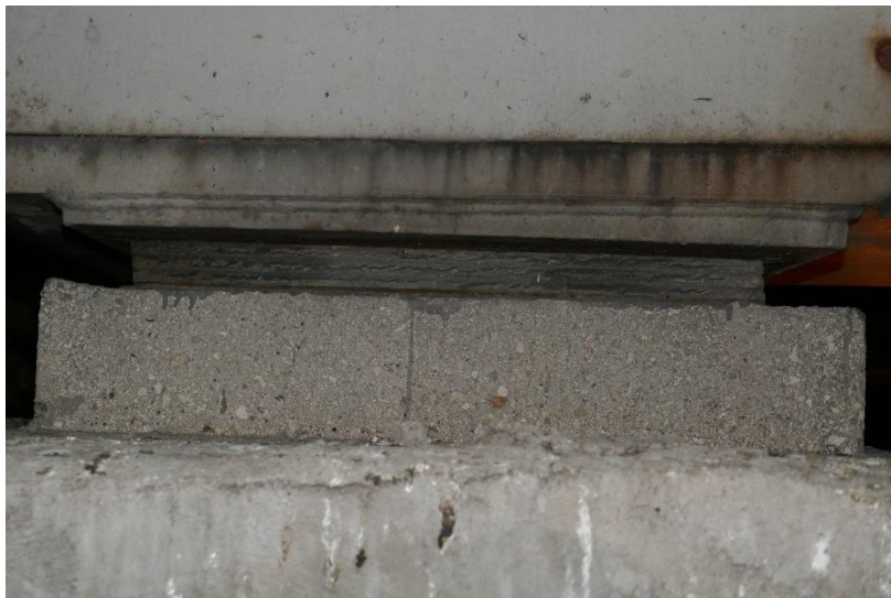
Photo 46 APPAREILS D'APPUI : Distorsion longitudinale de 2 mm vers le Nord avec gerçures et boudinage de l'élastomère de l'appareil d'appui Nord de la pile P3
