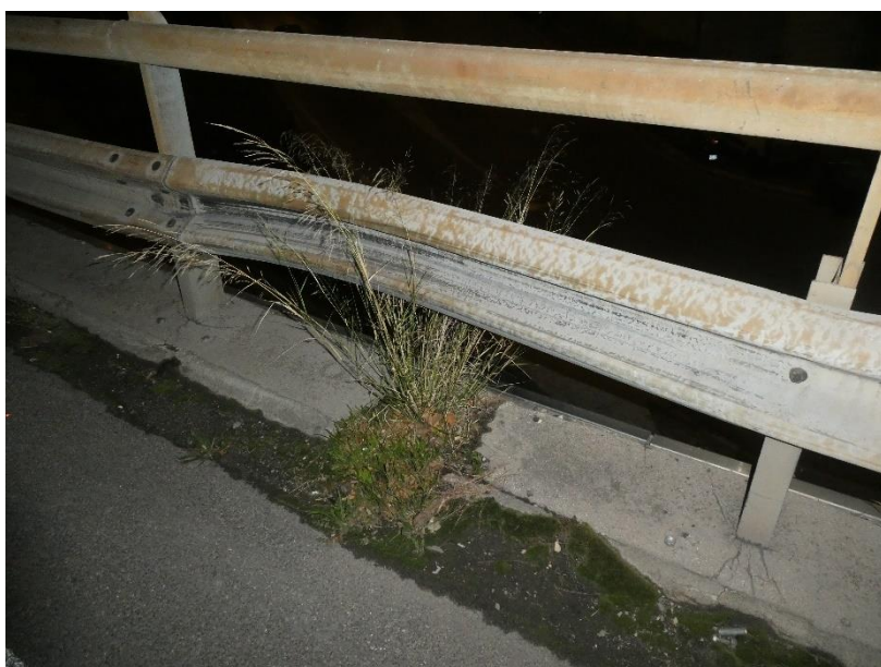
Photo 9 EQUIPEMENTS : Déformation de la glissière de sécurité Sud en travée TR2, au droit de la pile P2, et éclats de béton en formation en pied des montants
