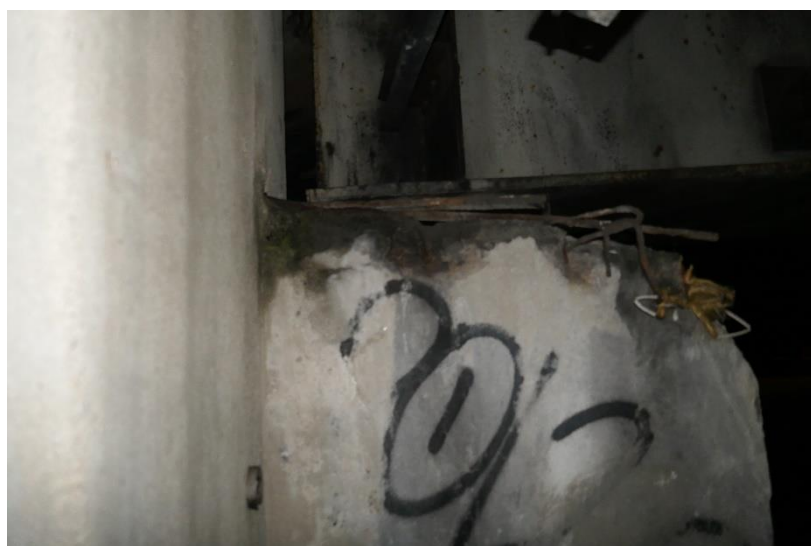
Photo 24 APPUIS - CULEES : Eclat de béton avec aciers apparents foisonnés à l'extrémité Nord du mur de front de la culée C0'
