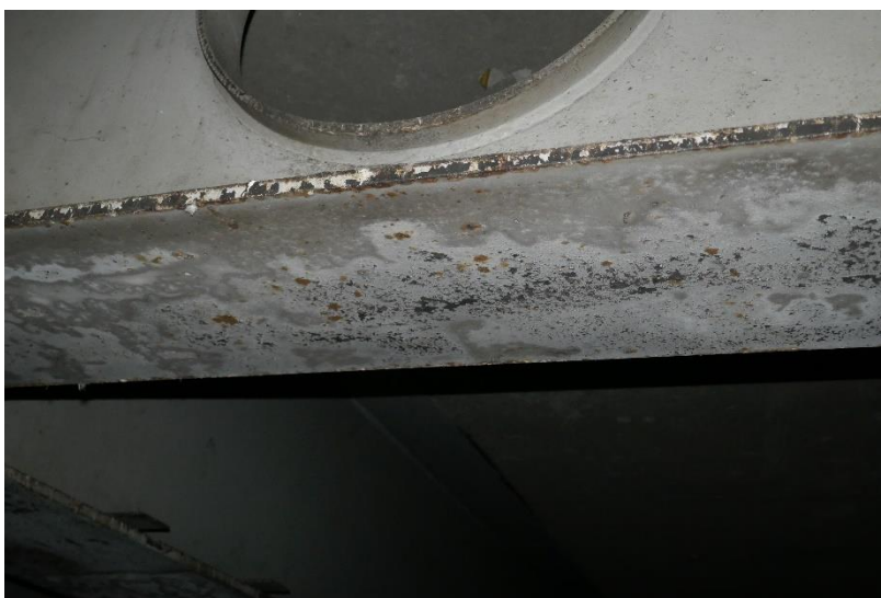
Photo 20 TABLIER - ENTRETOISES : Ecaillage de la protection anticorrosion et piqûres de corrosion au niveau de la semelle inférieure de l'entretoise E5 en travée TR2, entre PoT01 et PoT02
